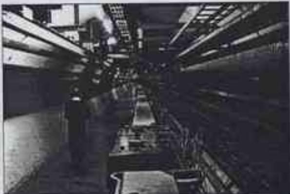
L.E.P. (Large Electron Positron Collider) qui, sur une circonference de 27 km, accélère des électrons et des positons (électrons positifs) en sens inverse et les fait se rencontrer en 4 points de collisions. Les précédents accélérateurs constituent avec le L.E.P. un ensemble unique au monde (1991). En effet, quand le L.E.P. fonc-
