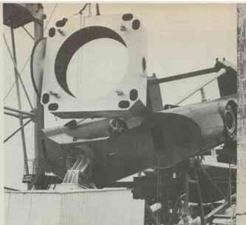
Fig. 3 - Le montage du télescope à la Rochelle-Pallice. Le caisson central est apporté par un pont roulant pour être mis en place sur la monture. On voit l'empêchement d'entrainement sur un des flancs du caisson.
