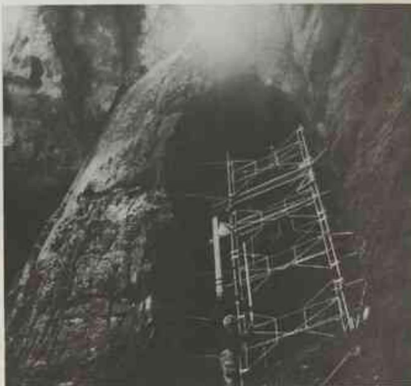
Installation d'un échafaudage au fond d'une cavité de 25 m. Gisement oligocène de Fech-Crebit.
