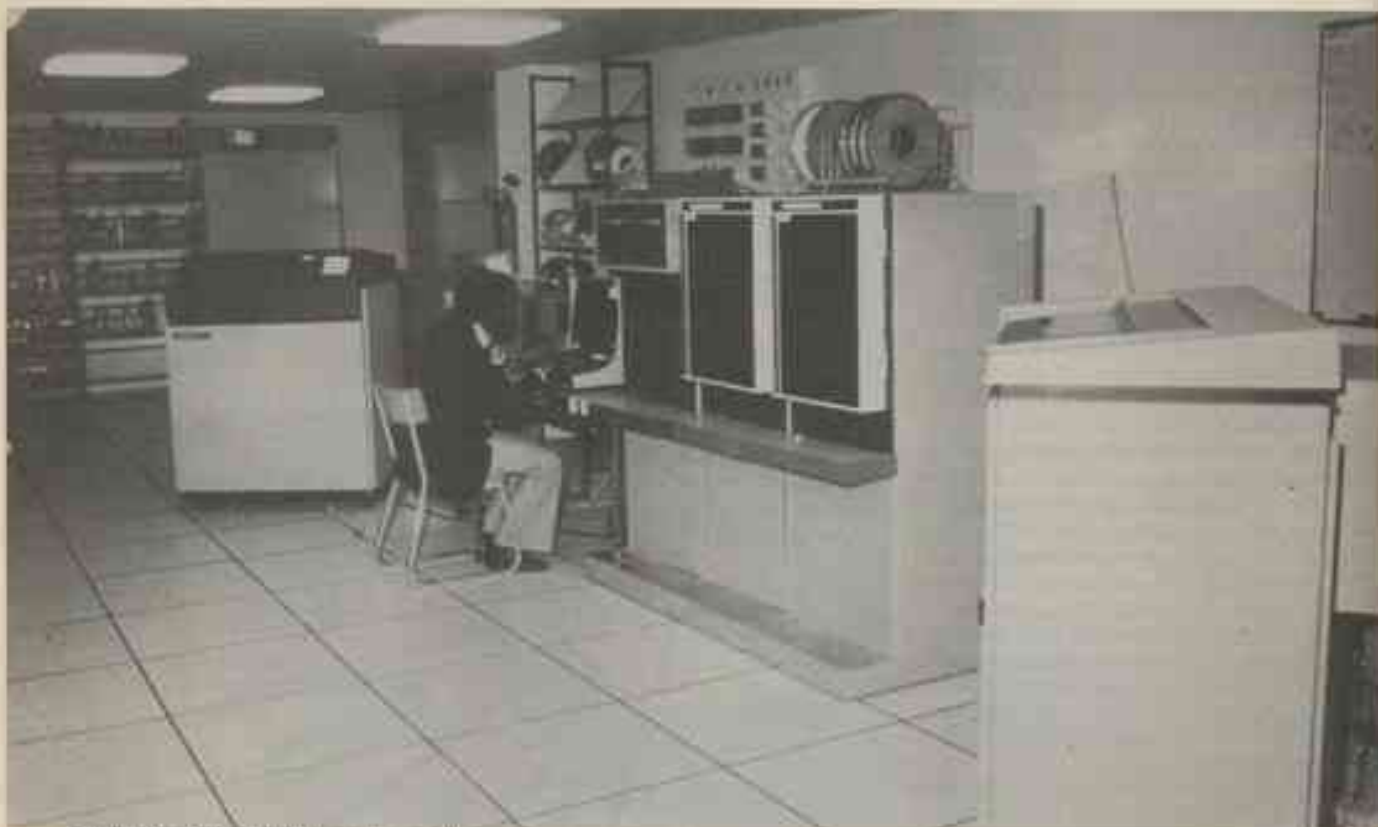
Terminal lourd pour traitement « en différé »
