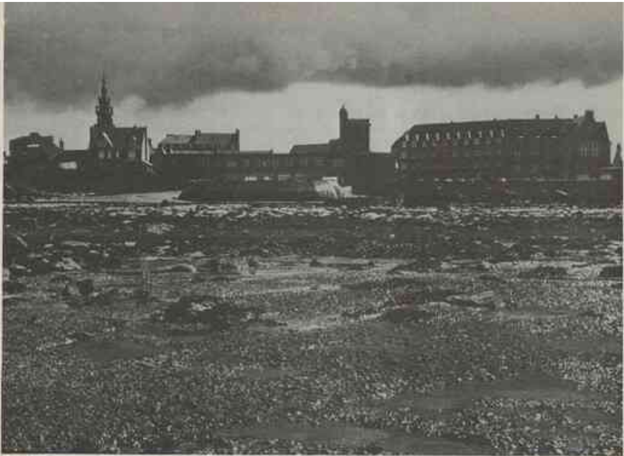
Photo 1 - Vue générale du laboratoire prise de la mer à marée haute. À droite les nouveaux bâtiments du CNRS.
