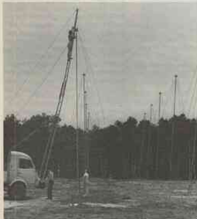
Fig. 5 - Montage d'une antenne. Approchée sur une flèche au-dessus d'un camion, elle est transportée du gabarit à sa position définitive dans le réseau.
