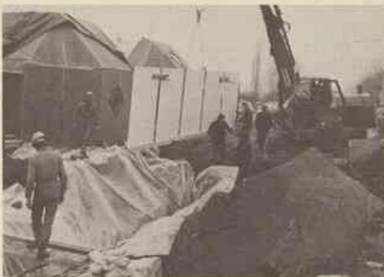
Mise en place des échangeurs (radiateur plan) dans des tranchées lors de l'expérimentation de stockage interaisonnel de chaleur en sous-sol réalisée par l'Institut de mécanique de Grenoble (LA 6).
