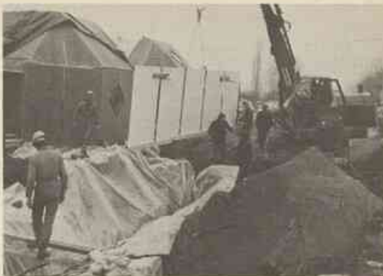
Mise en place des échangeurs (radiateur plan) dans des tranchées lors de l'expérimentation de stockage inter saisonnier de chaleur en sous-sol réalisée par l'Institut de mécanique de Grenoble (LA 6).
