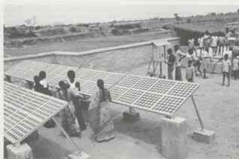
La pompe solaire du village de Saran (Etat du Bihar, Inde). ASVAL/applications solaires dans les villages de l'Inde. © CNRS/Photo P. Amato
