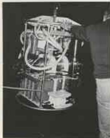
Mise en œuvre, au cours de la campagne Fixantante 1985 (voir résultats marquants), à bord du NO "Le Surp", d'un instrument de haute technologie pour l'étude de la matière en suspension dans l'océan. Cet ensemble dénommé POP (Particules Océan Profondes) permet la filtration par pompage de grands volumes d'eau de mer jusqu'à 2 000 mètres de profondeur (filtrations séquentielles sur quatre vases commandées à bord du navire : environ 1 m<sup>3</sup> ; 4 heures d'autonomie).
