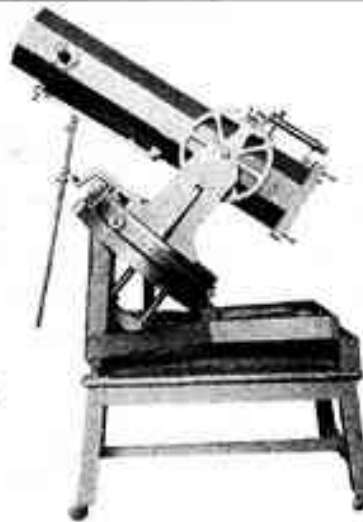
Petit télescope de Foucault, 20 cm d'ouverture.
