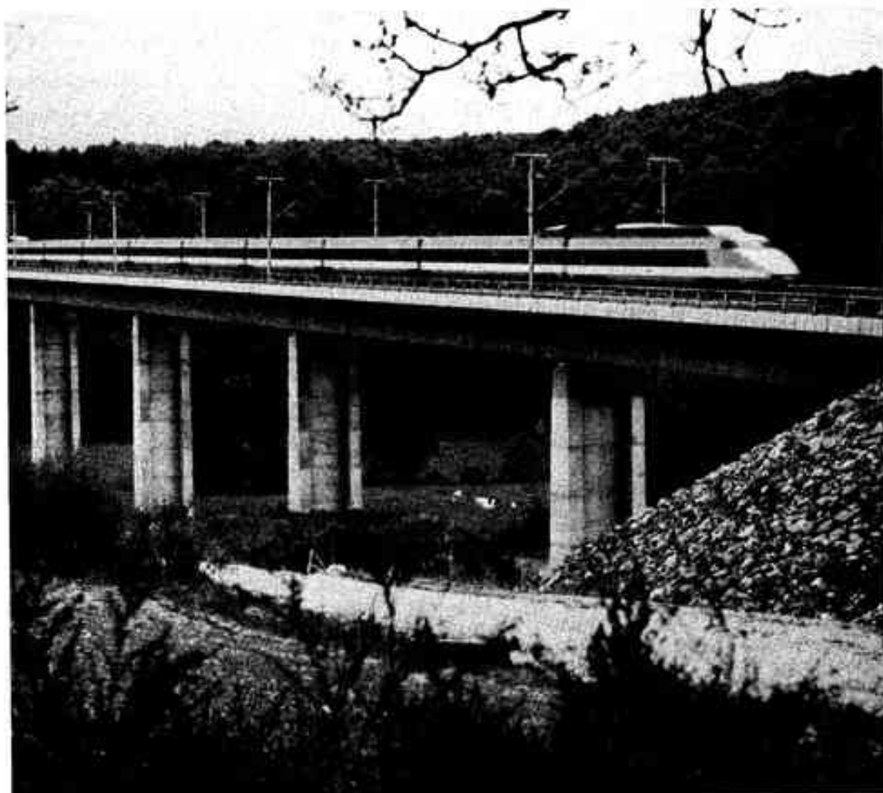
La ligne nouvelle Paris-Sud-Est. Le viaduc de la Digoine en Saône-et-Loire. (Cliché SNCF-CAV).
