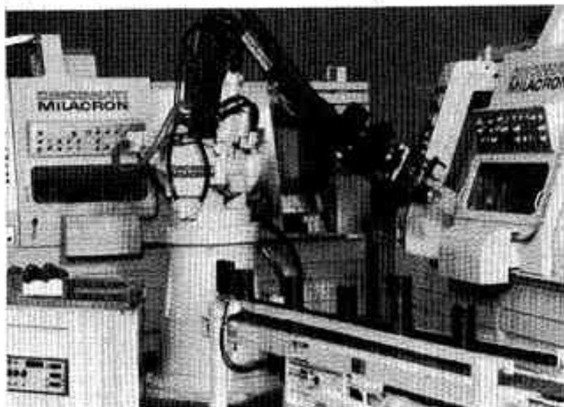
1 – Robot hydraulique dans une application de première génération : la saisie des pièces et le chargement de la machine outil se font dans des conditions de répétabilité géométrique absolue.
