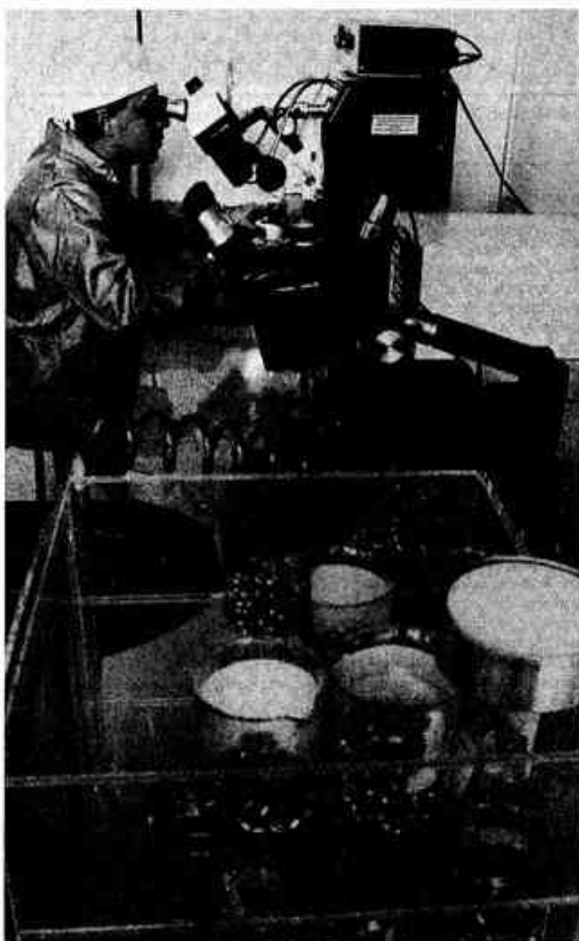
Technologie silicium et arsenic de gallium. Microsoudure des connexions des circuits. Liaison par fil de diamètre 25 microns du composant aux sorties du boîtier. LAAS, Toulouse. (Photo Ph. Piailly - CNRS, octobre 1982, 23).
