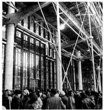
L'acier centrifugé : un exemple de nouveau matériau permettant de nouvelles formes à l'architecture contemporaine (Cliché Centre G. Pompidou).
