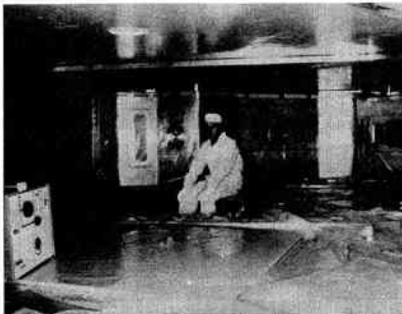
Nettoyage à l'intérieur d'une chambre à vide d'un cyclotron à secteurs séparés (CSS). Les chimistes du GANIL ont mis au point des solutions spéciales pour le nettoyage et le dégraissage des différentes pièces. Ainsi certaines parties en acier très doux restent en contact de l'air sans être rouillées à condition de ne pas y toucher avec les mains. (GANIL - CEA-IN2P3-CNRS).
