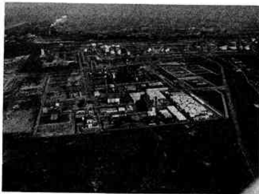
Les installations de polyéthylène de CdF Chimie à Dunkerque. © Marie-Françoise Lantier.
