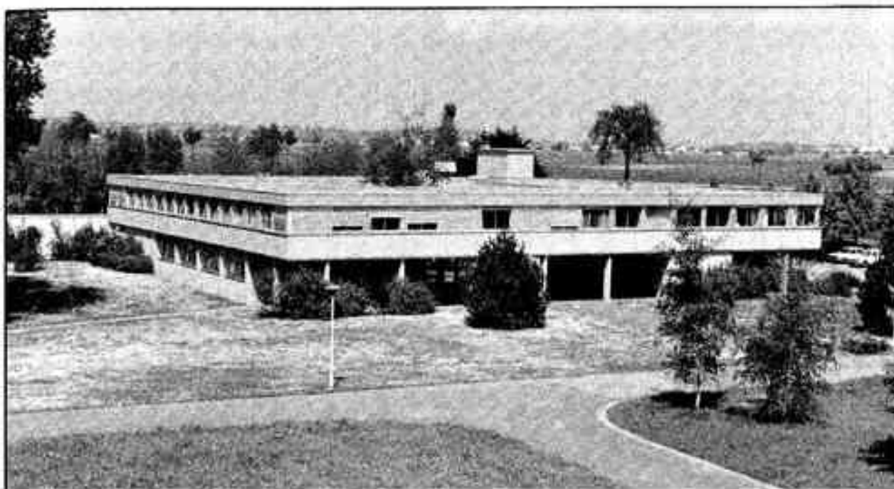
Vue d'ensemble du Laboratoire de physiologie respiratoire. L'architecture n'est nullement orientée vers l'économie d'exploitation (forme plate, patio, étagement des surfaces, etc.). Le rapport surface/volume est particulièrement élevé.
