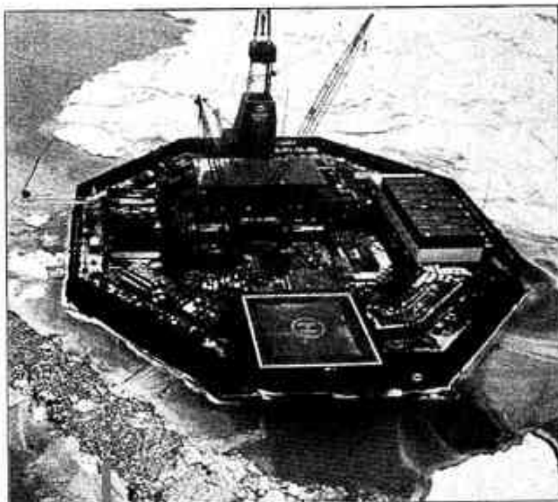
Carriçon en béton : île artificielle pour forage pétrolier en mer de Beaufort (Cliché Canadian Petroleum Association).
