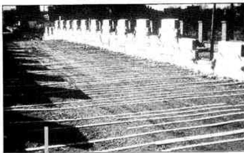
Construction d'un ouvrage en terre armée.
