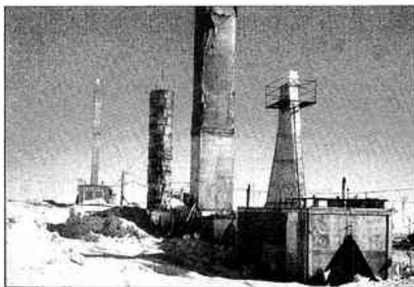
Fig. 1. Carottage en Antarctique. Les forages profonds dans la glace posent des problèmes spécifiques, il faut utiliser un fluide pour éviter la fermeture du trou et contrôler de nombreux paramètres à distance. Une campagne nécessite le transport de dizaines de tonnes à des centaines de kilomètres des stations d'appui côtières, dans un milieu particulièrement inhospitalier. À la station Vostok, située à 3 500 m d'altitude, la température moyenne annuelle est de -56^\circ\text{C} .
