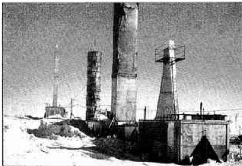
Fig. 1. Carottage en Antarctique. Les forages profonds dans la glace posent des problèmes spécifiques, il faut utiliser un fluide pour éviter la fermeture du trou et contrôler de nombreux paramètres à distance. Une campagne nécessite le transport de dizaines de tonnes à des centaines de kilomètres des stations d'appui côtières, dans un milieu particulièrement inhospitalier. A la station Vostok, située à 3 500 m d'altitude, la température moyenne annuelle est de  $-56^\circ\text{C}$ .
