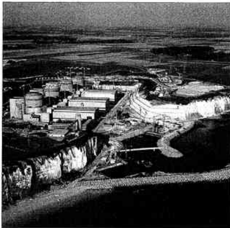
Centre de production nucléaire de Paluel (Seine-Maritime). (© SODEL EDF, diffusion La Documentation française, cliché Briquand). Les interrogations concernant le ralentissement ou l'arrêt des programmes nucléaires ne sont qu'un des aspects de la prise en compte des considérations d'environnement sur la scène de l'économie du secteur énergétique.
