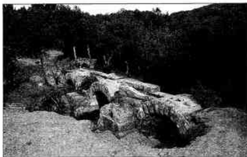
Le pont de Bornègre.
