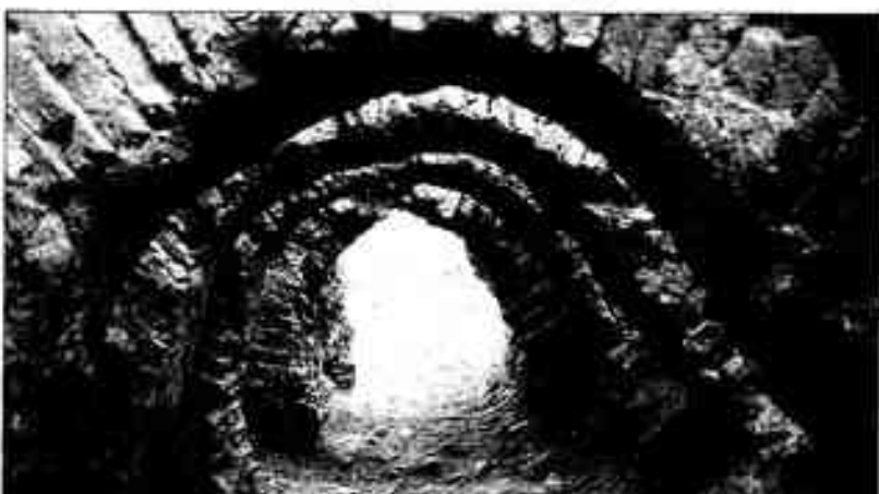
Fig. 3. Salle de chauffe du four à sole circulaire : les arcs de briques soutiennent la sole circulaire où sont disposées les céramiques à cuire. (Cliché F. Laubenheimer).
