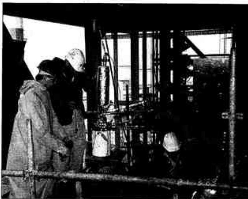
Prélèvement de mélange réactionnel dans un craqueur industriel. (Cliché J.-R. Bernard).
