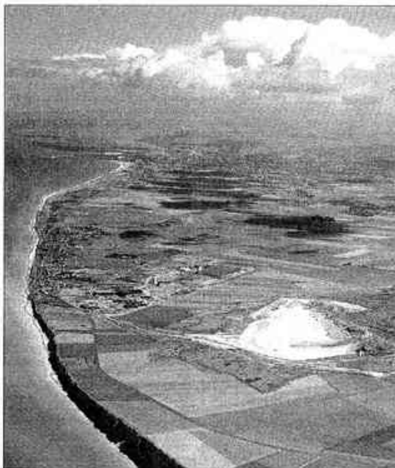
Tunnel sous la Manche, vue aérienne du chantier extérieur (© Cliché PHOT'r). Les contrats internationaux permettant la mise sur pied d'entreprises aussi complexes.
