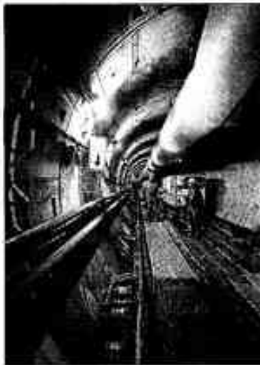
Creusement du tunnel sous la Manche. (© Cliché Poteau/TML).
