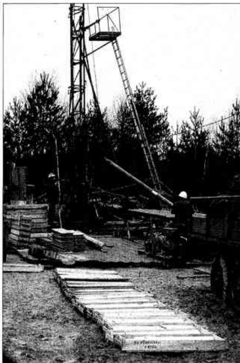
Une installation de forage (Echassières) et les carottes qui ont été prélevées.
