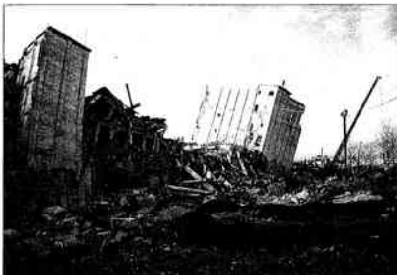
■ Destructions provoquées par le séisme de Spitak (Arménie), le 7 décembre 1988. Ce tremblement de terre, de magnitude 6,2, a fait environ 25 000 morts. On observe ici certains édifices totalement détruits, d'autres basculés en bloc. (Cliché H. Philip).
