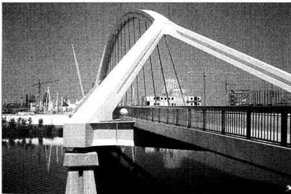
Le 24 avril 1992, l'exposition universelle de Sivile à laquelle participera le CNRS ouvrira ses portes; elle a donné lieu à de gigantesques travaux, en particulier six nouveaux ponts lancés sur le Guadalquivir - (D. PEA, P. Grifon).
