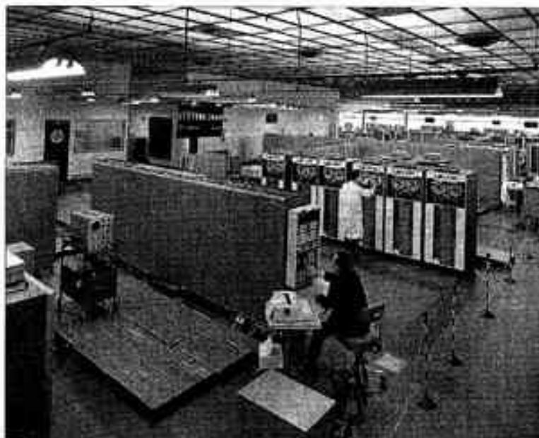
Machine IBM 7040 à transistors (archives IBM). Produite à partir de 1963, cette machine de 30 tonnes possédait une mémoire à tores de ferrite de 200 Koctets. Les entrées de données se faisaient sur cartes perforées et les sorties sur imprimante. Le cycle de base était de 2 microsecondes.
