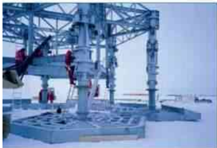
Montage sur verges de la base Concordia
