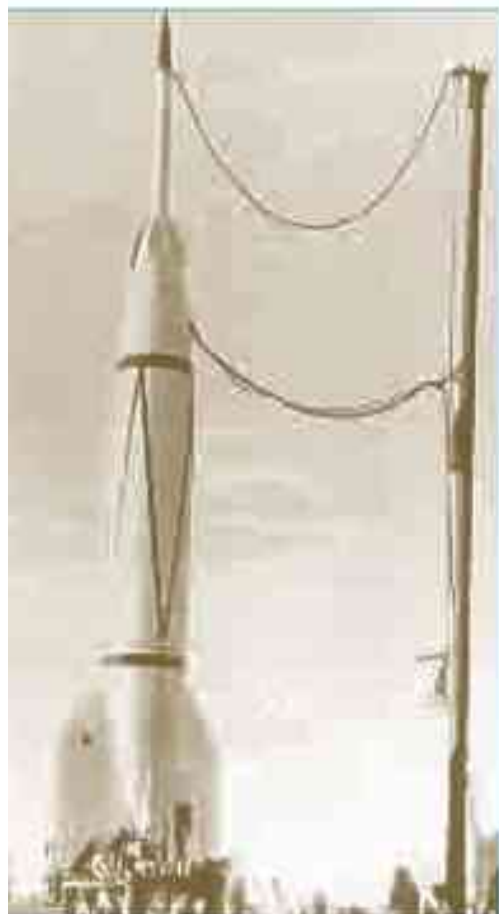
Fig. 7 - V-2 avec WAC-Corporal en 2 e étage, sur le pas de tir de White Sands V-2 with a WAC-Corporal second stage on the White Sands launch pad.
