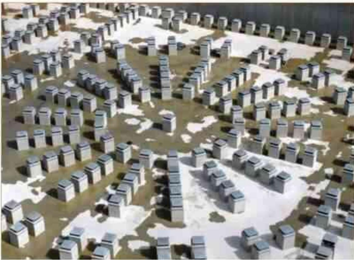
Avril 2012, fin de la première phase des travaux dans la fosse du tokamak. A 17 mètres de profondeur, le socle de béton, les murs de soutènement et les plots parapataques de la fosse d'isolation sismique sont en place.
