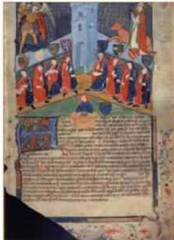
1440 : construction du pont couvert sur la Garonne
