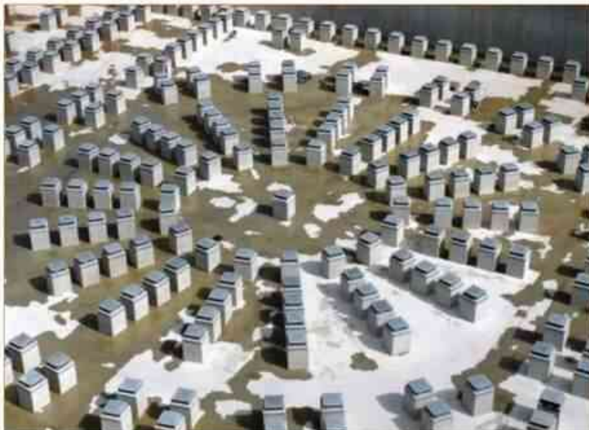
Avril 2012, fin de la première phase des travaux dans la fosse du tokamak. A 17 mètres de profondeur, le soker de béton, les murs de soutènement et les plots parasismiques de la fosse d'isolation sismique sont en place.
