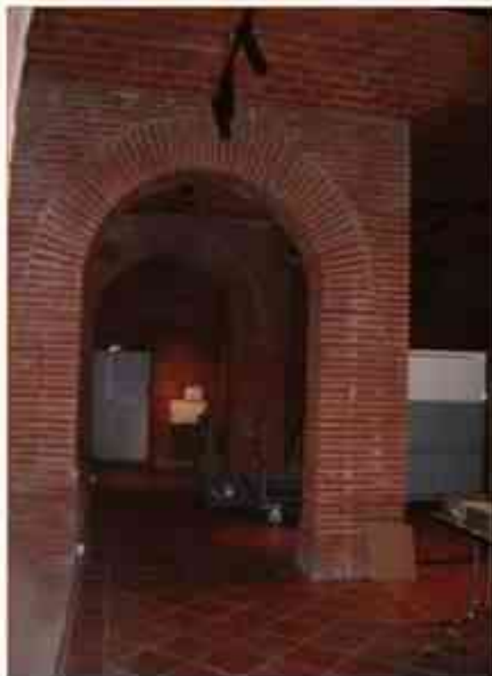
Une des galeries en sous-sol
