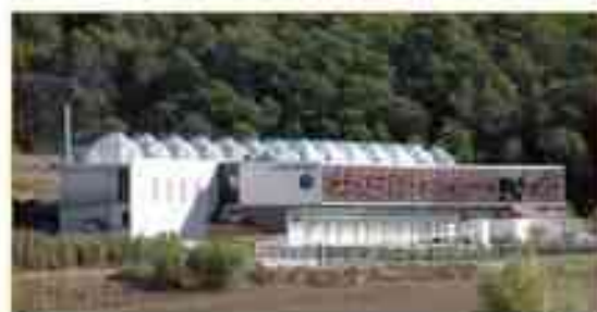
Photo 1 Vue générale de l'Écotron. Nous apercevons les toits en tôle ondulée des macrocosmes. Ce matériau a la propriété de résister à long terme au rayonnement solaire. Il impose peu de chaleur ce qui est essentiel pour la photosynthèse de la végétation (photo Jacques Roy).
