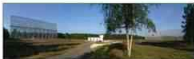
Figure 8. Le grand radiotélescope de Nançay, état vers 1995. On voit à gauche le miroir plan de 200x40 m, orientable autour d'un axe est-ouest, qui renvoie le rayonnement radio du ciel sur le miroir concave fixe de 300x35 m, à droite. Celui-ci concentre le rayonnement sur une antenne locale placée sur le chariot mobile visible au centre. Le bâtiment de réception visible derrière le chariot est actuellement déplacé en dehors du trajet des ondes radio.
