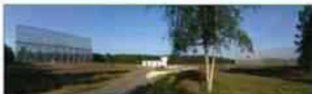
Figure 8. Le grand radiotélescope de Nançay, état vers 1995. On voit à gauche le miroir plan de 200x40 m, orientable autour d'un axe est-ouest, qui renvoie le rayonnement radio du ciel sur le miroir concave fixe de 300x35 m, à droite. Celui-ci concentre le rayonnement sur une antenne focale placée sur le chantier mobile visible au centre. Le bâtiment de réception visible derrière le chantier a été actuellement déplacé en dehors du trajet des ondes radio.
