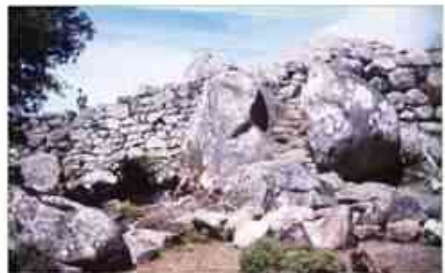
Levée (Corse du Sud) : village de l'âge du Fer de Cucunizza : travaux de réfection du mur d'enceinte, vue de l'intérieur. Contre le mur d'enceinte quartier des loges des artisans (1990)
