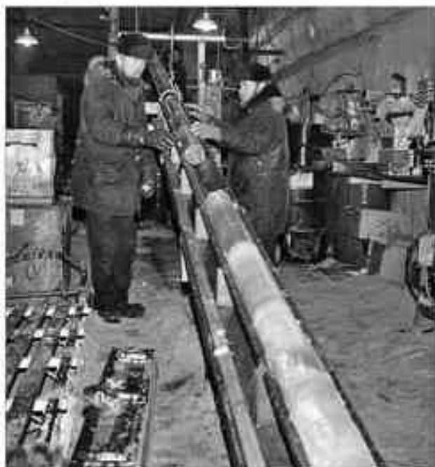
Fig. 2. Carotte de glace extraite par les ingénieurs du Gold Regions Research and Engineering Laboratory de l'armée des États-Unis à Camp Century, Groenland. (Photo ERDC Gold Regions Research and Engineering Laboratory, domaine public)
