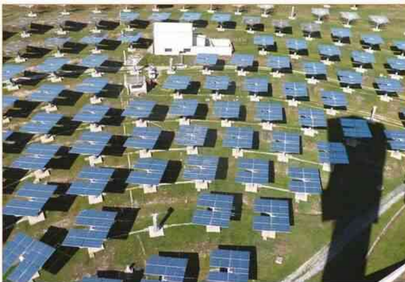
Photo 4. Vue du champ d'héliostats de Thémis. Nous sommes ici à 50 m au-dessus du sol. C'est à ce niveau, celui du récepteur central, que se mettent en place les expérimentations du programme PHÉLIX. L'ombre de la tour est visible sur la photo. Ici, les héliostats sont en position de repos. Ils sont pilotés par deux programmes informatiques mis en place, un programme superviseur central et un programme embarqué dans chaque héliostat. Photo Serge Hambod.
