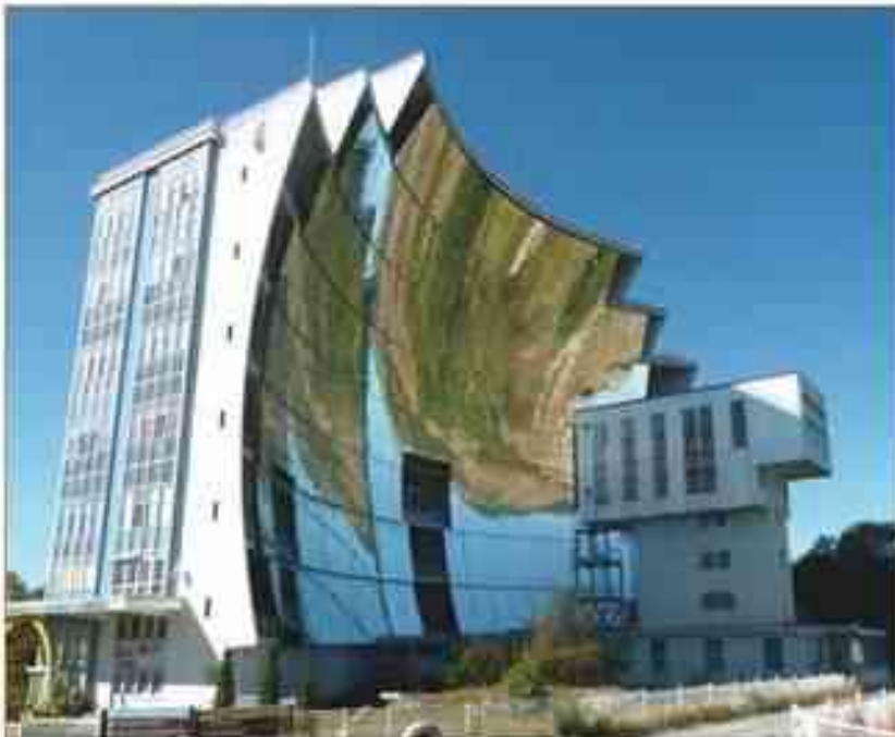
Photo 1. Vue générale du four solaire d'Odeillo adossé au bâtiment qui abrite à la fois des fours solaires de moyenne puissance et les activités du laboratoire. Photo Serge Rambol.
