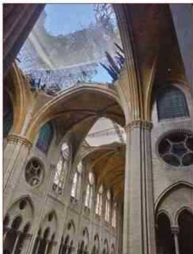
Ouverture dans la croisée du transept de Notre-Dame de Paris laissant apparaître des poutres carbonisées : ce sont les « thermosceptes fœdaux » de notre paléothermométrie Raman.
