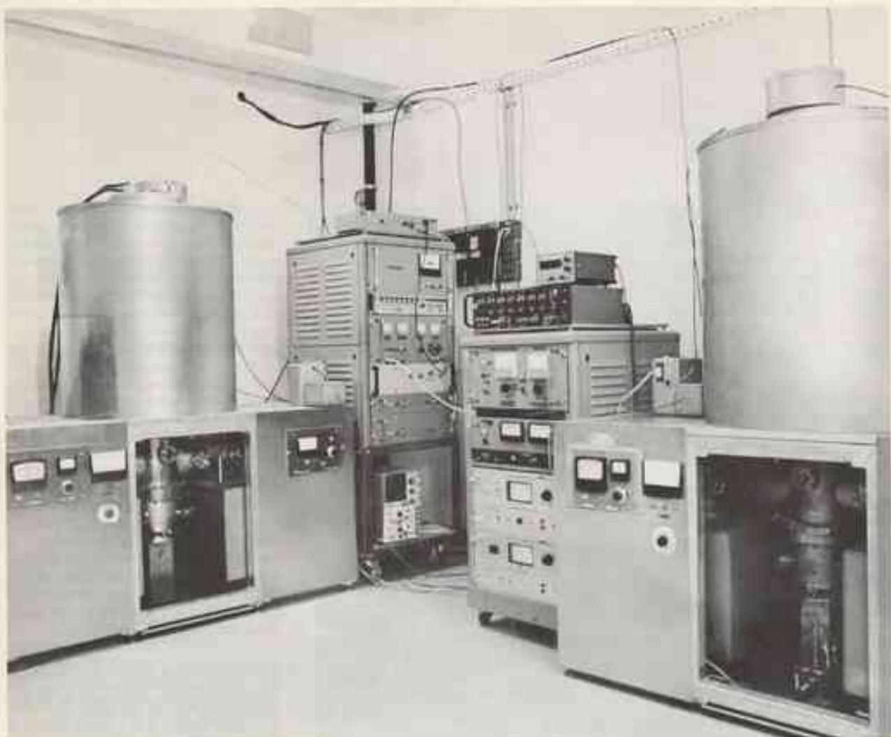
Photographie de deux horloges atomiques à hydrogène construites à Orsay.
