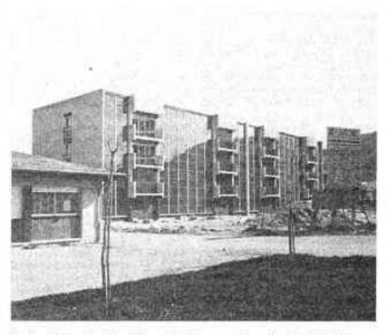
Fig. 1 – L'immeuble solaire de Bourgoin-Jallieu, construit par l'union des HLM, instrumenté par le plan-construction modélisé et expérimenté par une équipe du centre de recherches à très basses températures du CNRS, Grenoble.
