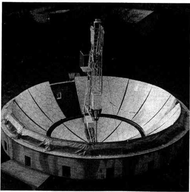
Fig. 5 – Le collecteur sphérique fixe muni d'une chaudière mobile PERICLES (Production d'énergie en région isolée per concentration limitée d'énergie solaire) a été conçu par le laboratoire d'astronomie spatiale de Marseille. Au prototype de 10 m de diamètre actuellement construit succèdera peut-être un modèle de 30 m bien adapté à la fourniture de chaleur et d'électricité aux villages indiens.
