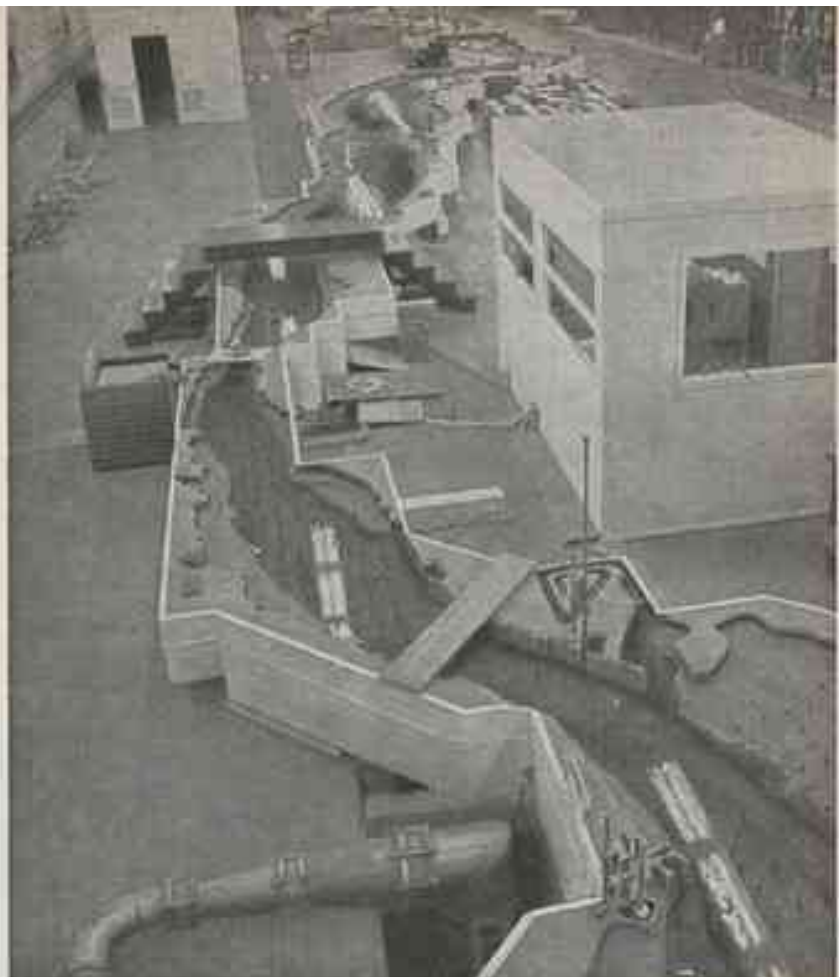
Modèle pour l'étude des marées du fleuve Saint-Laurent (Division de Génie mécanique).
