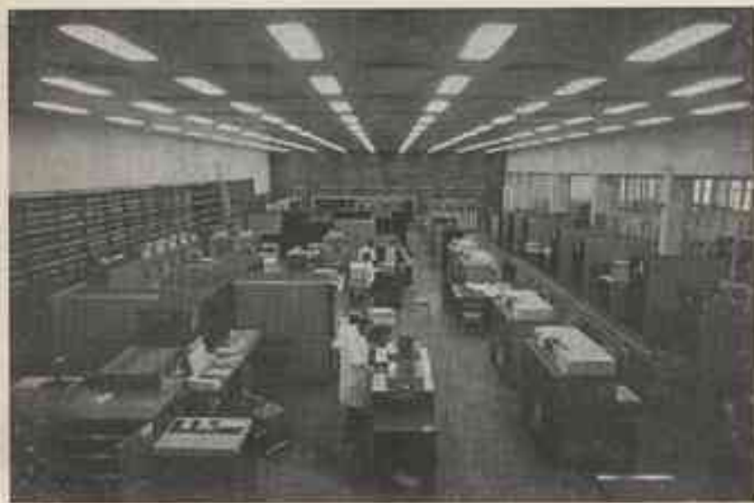
Salle des machines.
