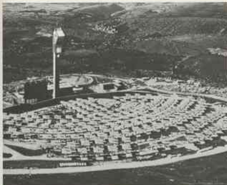
Carrière TIVEAM - Photo Codel photographique EDF.
