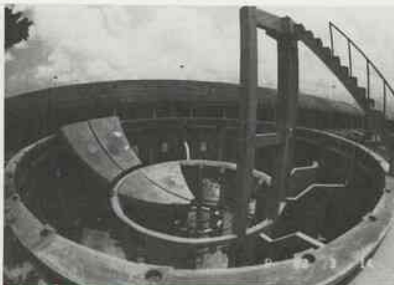
Prototype PERICLES en cours de remontage au Brésil.
