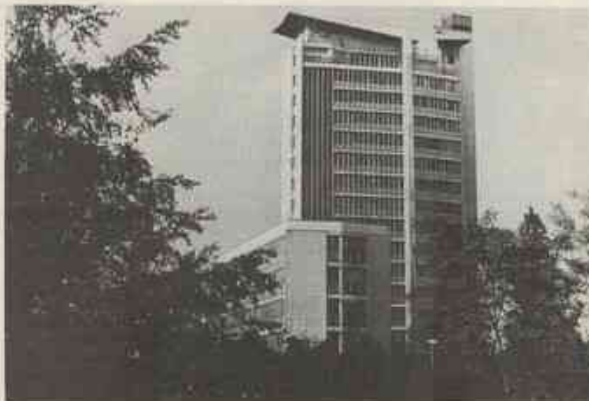
L'Institut de chimie de Strasbourg abrite dans le même bâtiment l'École Nationale Supérieure de chimie et les laboratoires d'enseignement et de recherche de chimie de l'Université. Ses formations sont liées au CNRS, localisées dans le même bâtiment et dans un bâtiment voisin. Mélanges en commun sous les manchettes d'aujourd'hui.
