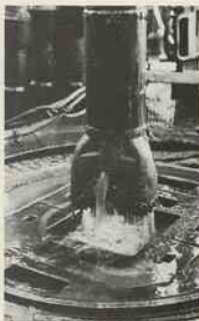
Un trou, à gauche, les trépanés neuf va être divisés au fond du trou pour poursuivre le forage.
