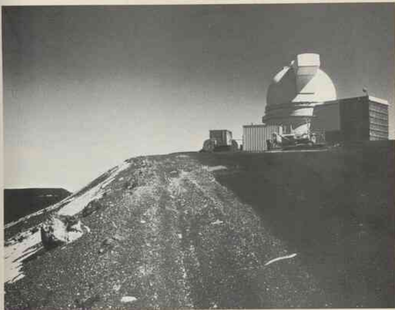
Vue en altitude de la côte supérieure du Mauna-Kea. A droite, le télescope de 2,20 m de diamètre de l'Université d'Hawaï. A gauche, au second plan, la plateforme où sera construit le télescope de 3,60 m (cliché INAG)
