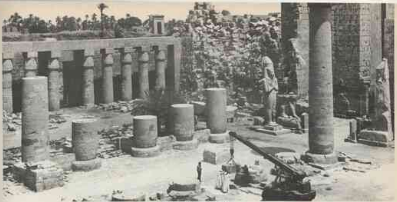
Travaux dans la grande colonnade
