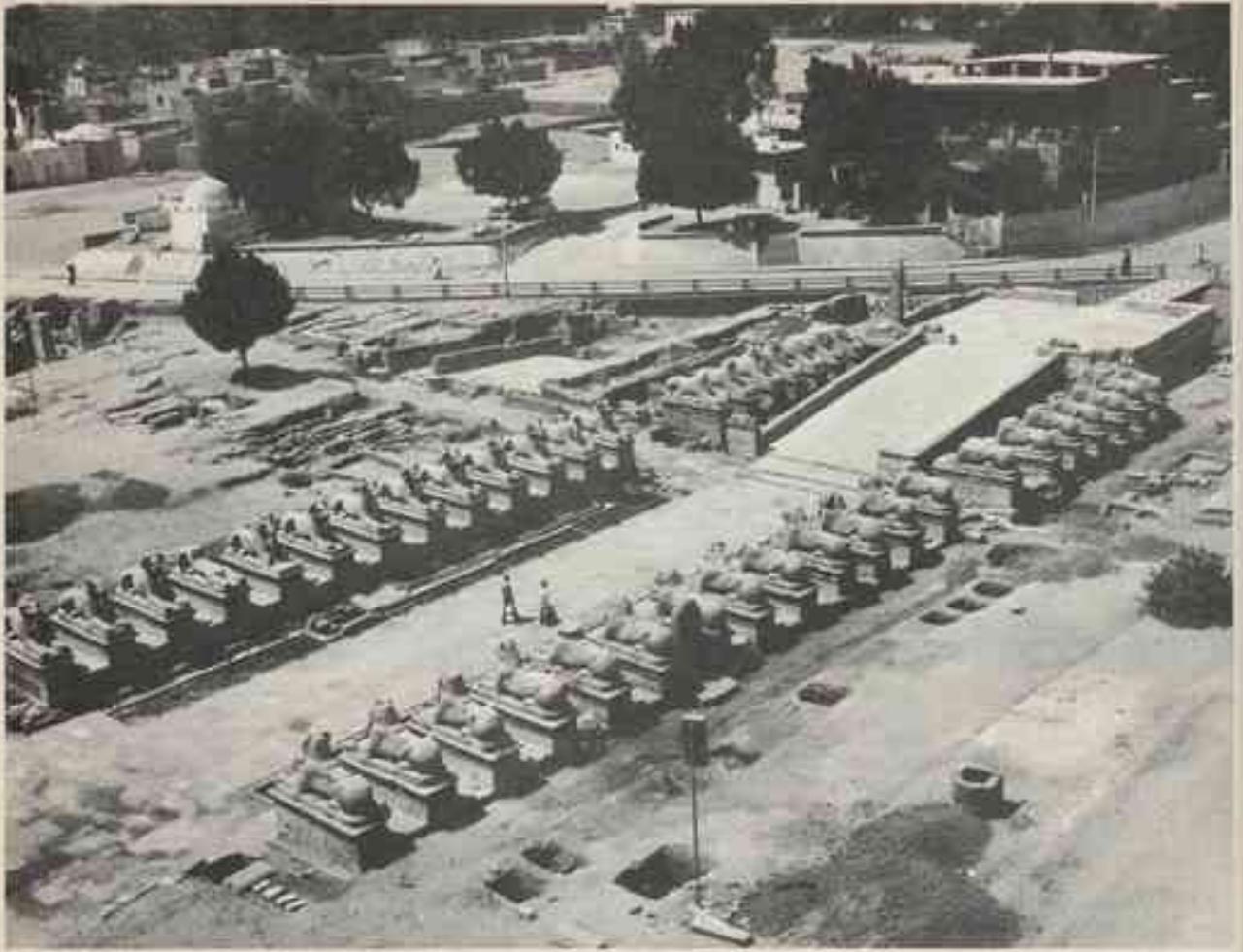
Fig. 2 : L'avenue des sphinx en cours de restauration (site A, Bellou)
