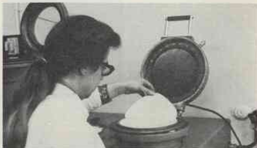
Détail de l'appareil précédent : la presse chauffante séche sur la feuille terminée pour l'usage ou l'état de découpe.
