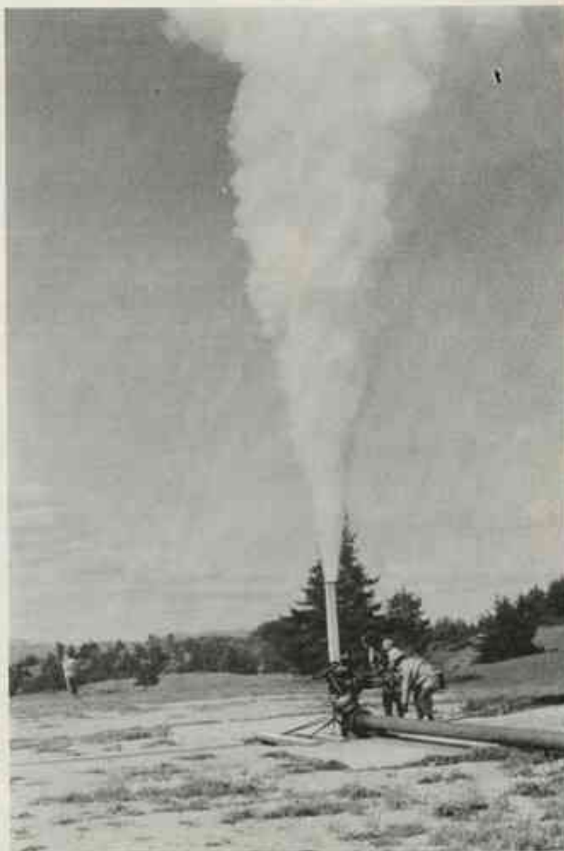
Eruption d'un sondage, à Waitakere, Nouvelle-Zélande. Le panache résulte ici de la vaporisation de l'eau du gisement et se compose en masse, de 25 % de vapeur et 75 % d'eau.
