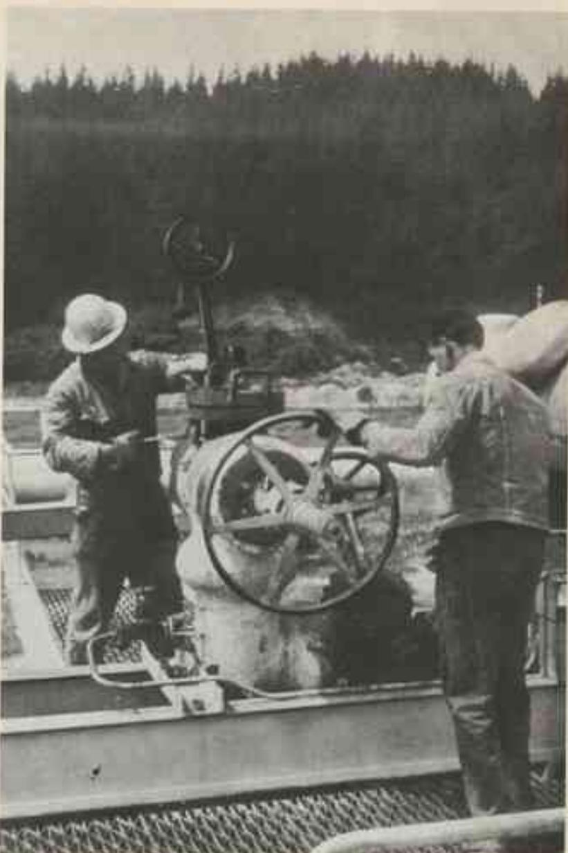
Mesure du puits thermique dans un puits. Le thermomètre enregistreur est placé dans le puits fermé.
