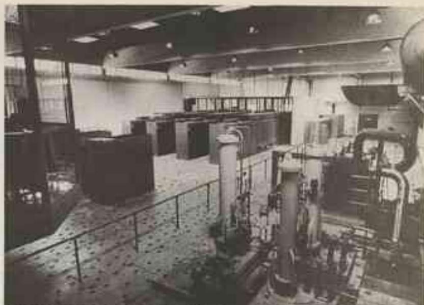
Fig. 1 : mise des machines à droite, l'installation hydraulique avec pompes, échangeur de température et élévateur à gauche, l'alimentation électrique avec transformateurs, les quatre alimentations statiques et les interrupteurs de régulation installés réalisée sous la responsabilité de J.C. Pioche et P. Rub, ingénieurs CNRS.
