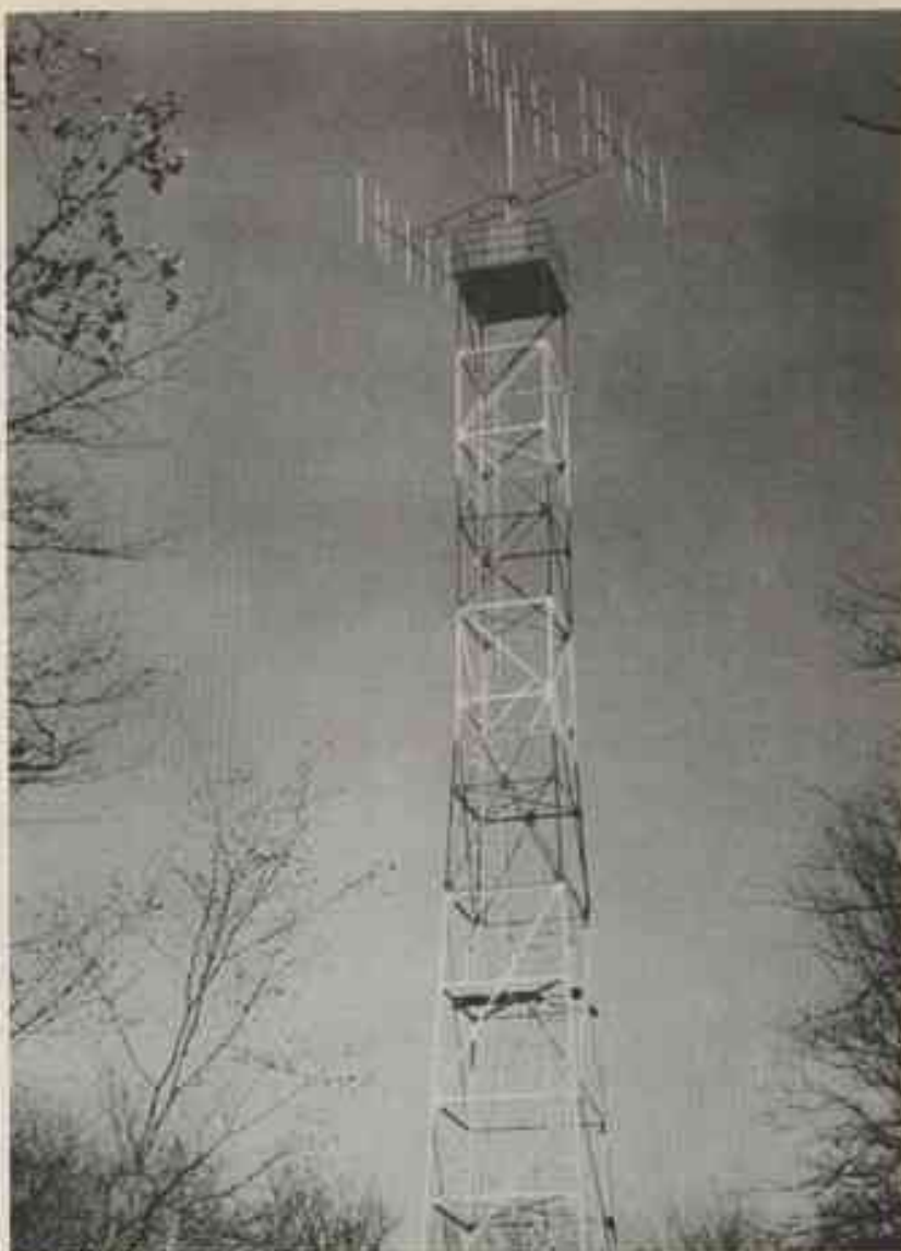
Fig. 2 - Un des trois pylônes de 30 m de hauteur supportant les antennes yagi destinées au radiotracking.
