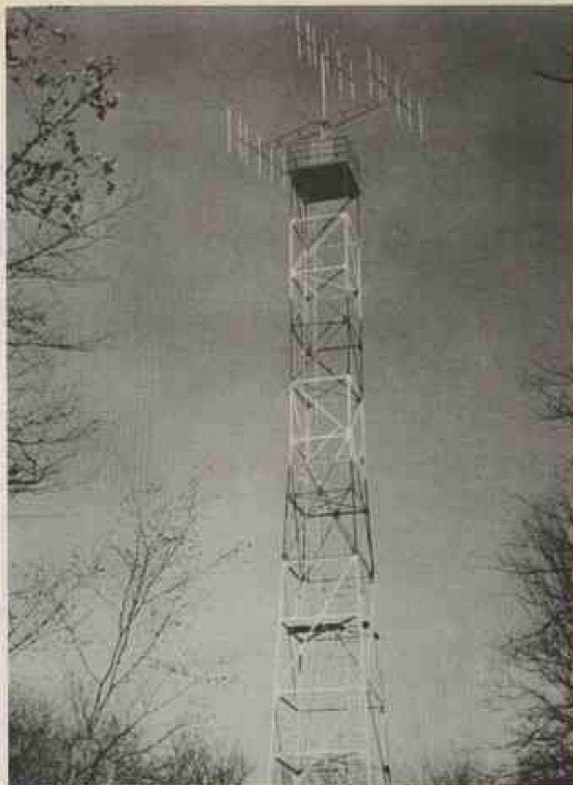
Fig. 2 - Un des trois pylônes de 30 m de hauteur supportant les antennes yogi destinées au radiotrackin.
