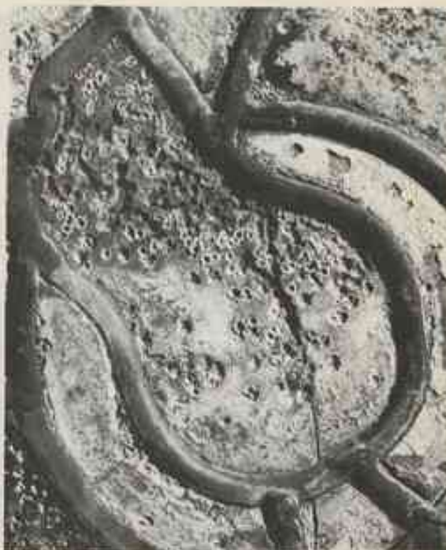
Fig. 2 - Altération uniforme; produits de corrosion composés de gypse et de syngénite (verre 12 e siècle, St Germain (de Corbail)).
