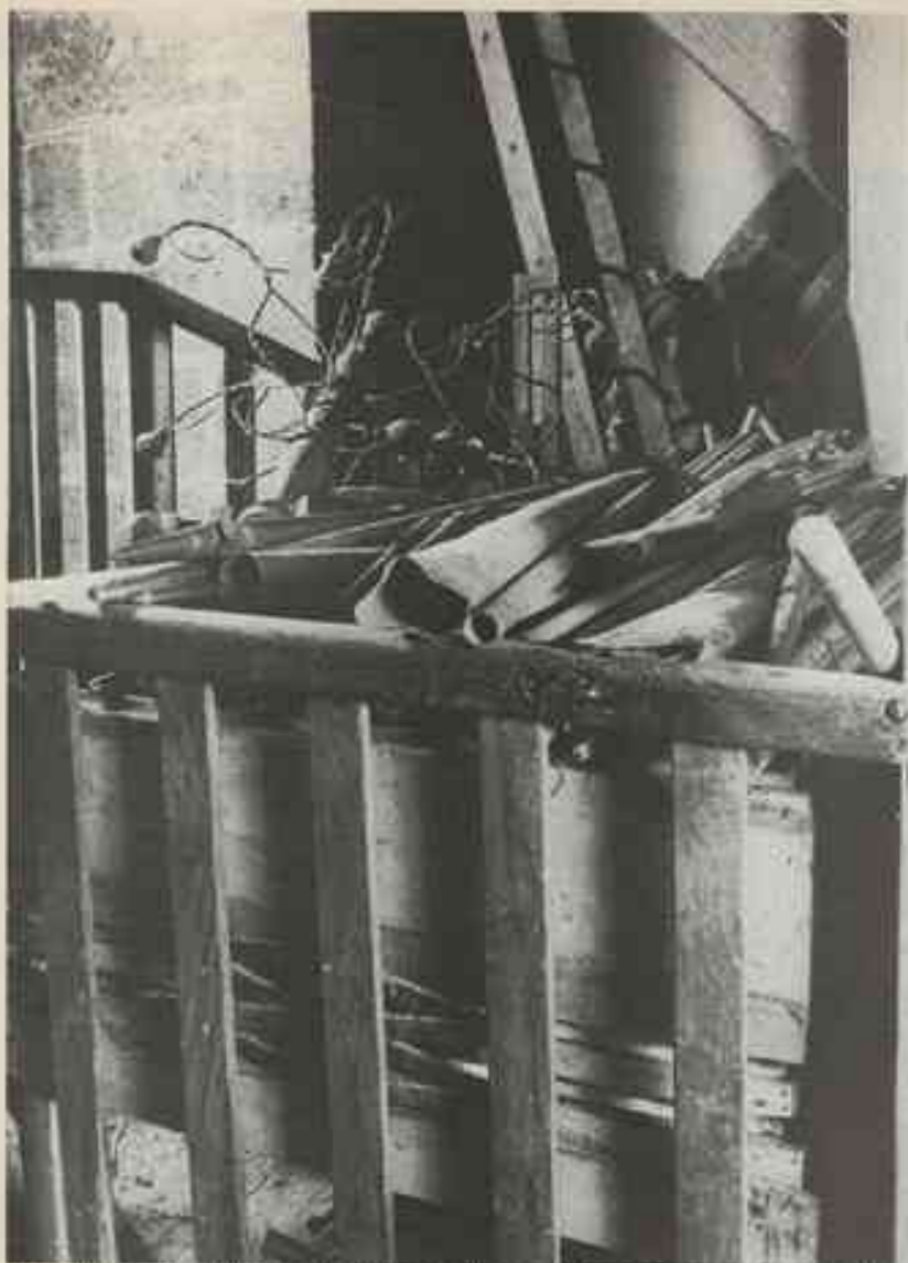
Fig. 2 - Lamoignon, Orgue. Intérieur du soufflet, état de la soufflerie et d'une partie de la tuyauterie au début de la mise au point.
