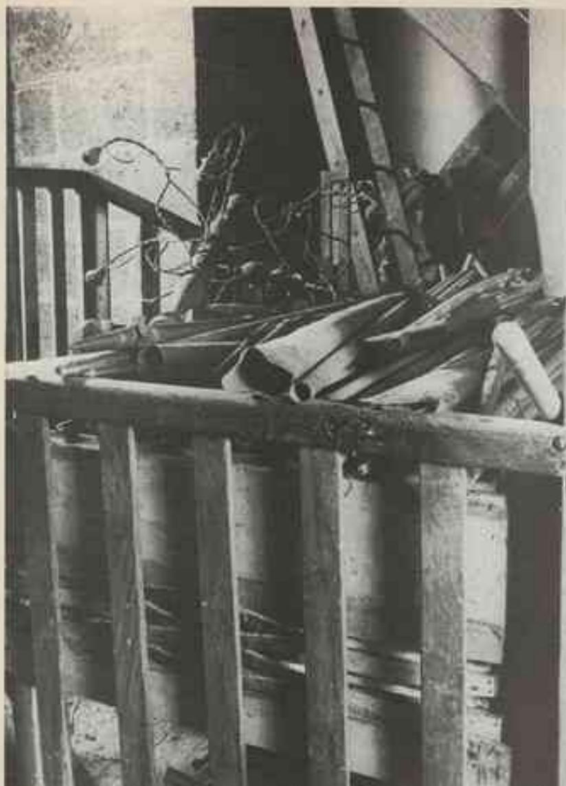
Fig. 2 - Lavaur, Orgue. Intérieur du buffet, état de la soufflerie et d'une partie de la tuyauterie au début de la rénovation.
