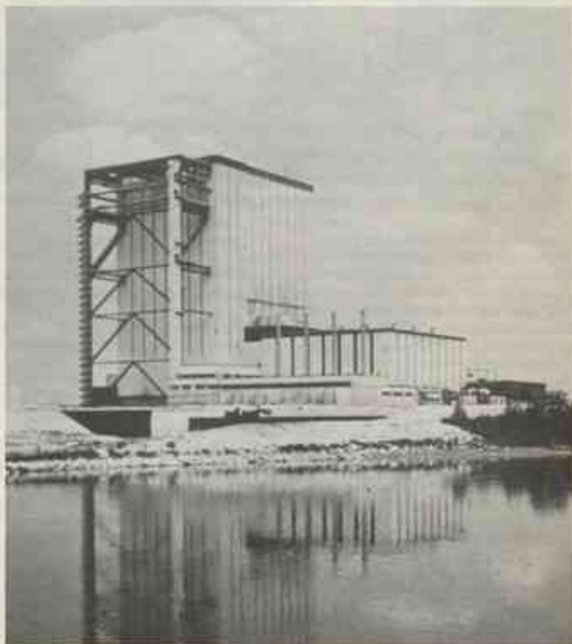
La centrale nucléaire de Bugey - (EDF)
